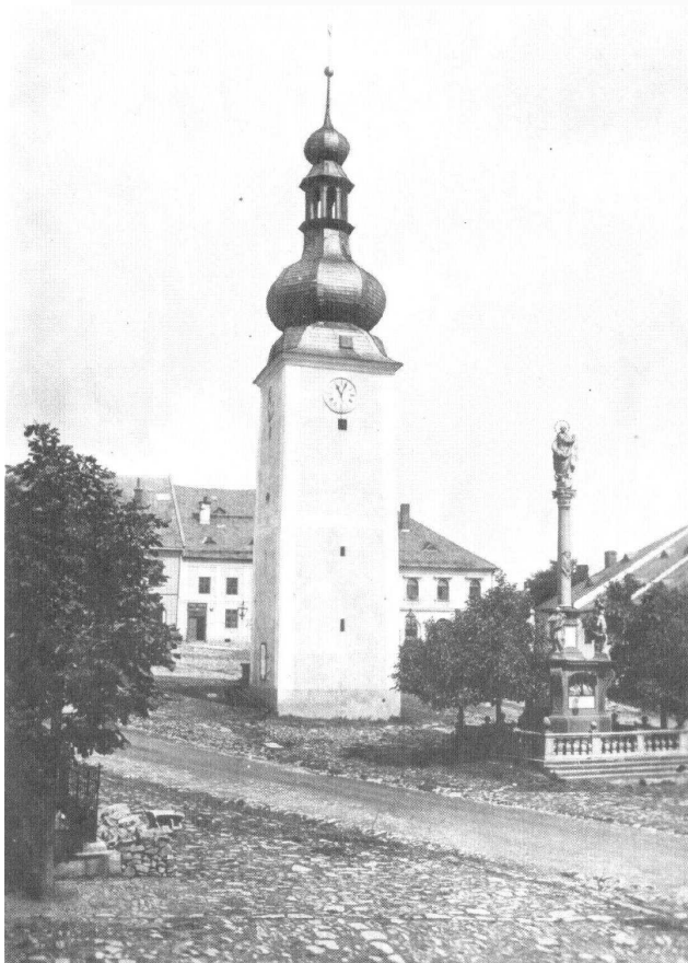
Náměstí s hodinovou věží a Mariánským sloupem [5]
