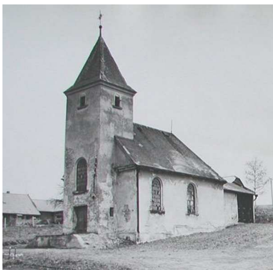
Kostel před rekonstrukcí...
