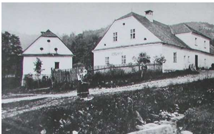
Bělský mlýn. Budova samotného mlýna dnes již nestojí, funguje zde však pstruhová sádka.
