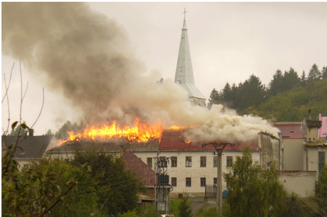
Potštát – požár továrny 22. září 2008 [archív města Potštát]
